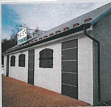
Remont szatni przy boisku sportowym w Studniskach Dolnych
