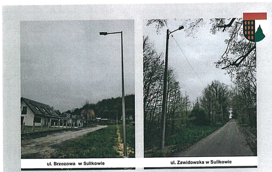
Rozbudowa oświetlenia na terenie Gminy Sulików
