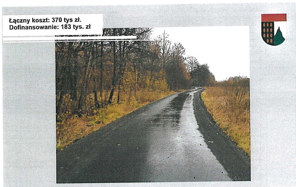
Przebudowa odcinka drogi z Ksawerowa do Wilki
